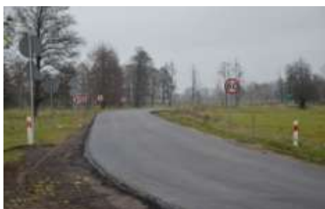
Odcinek drogi gminnej relacja Treblinka – Grądy
